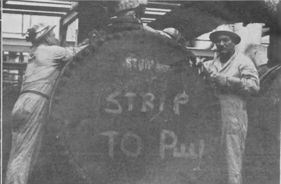
TUR COS mester worde bon gecheck for di e valvenan te na e pompan. E seccion pa conduci calor, banda robez, cu su tubonan halá afor, ta worde munstrá mientras e trahadornan ta cort'e le na pida chikito. E planchi dilanti, munstrá aya, banda drechi, lo worde kitá cu un derrick, y e grupo di tubonan p'aden halá afor.
